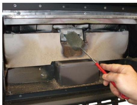
**Fig. 43 - Reinigung mit Flaschenbürste**
